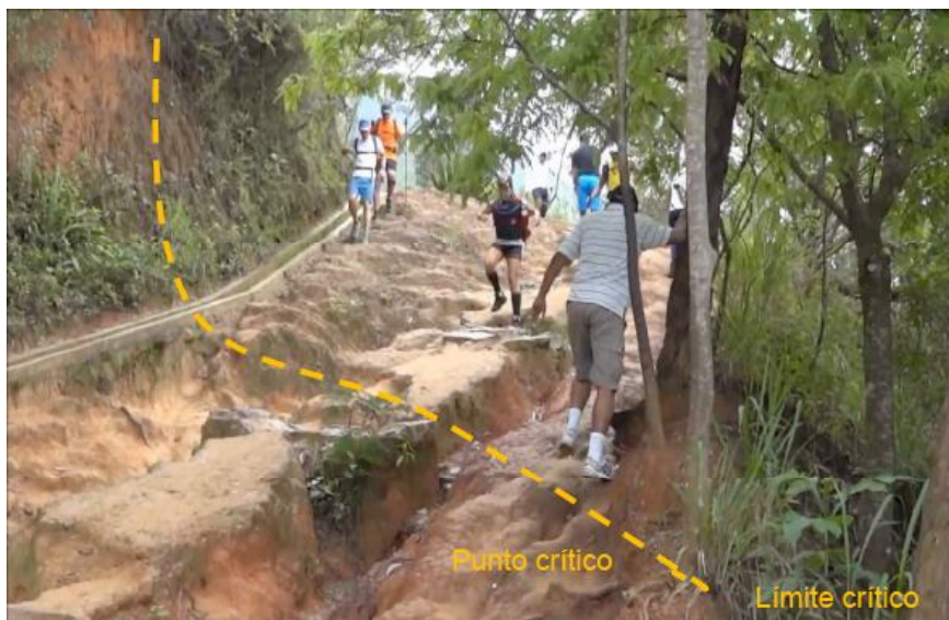
Figura 4. Erosión hídrica tipo cárcavas
