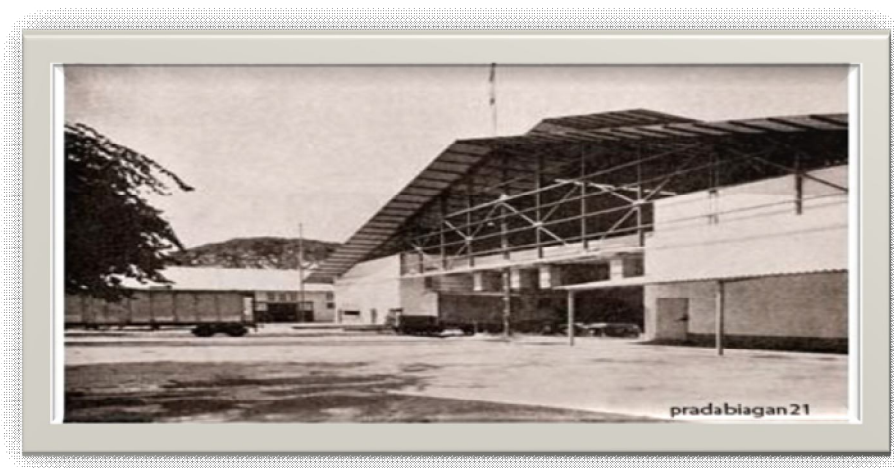
Figura 6 Edificios del Matadero Modelo
